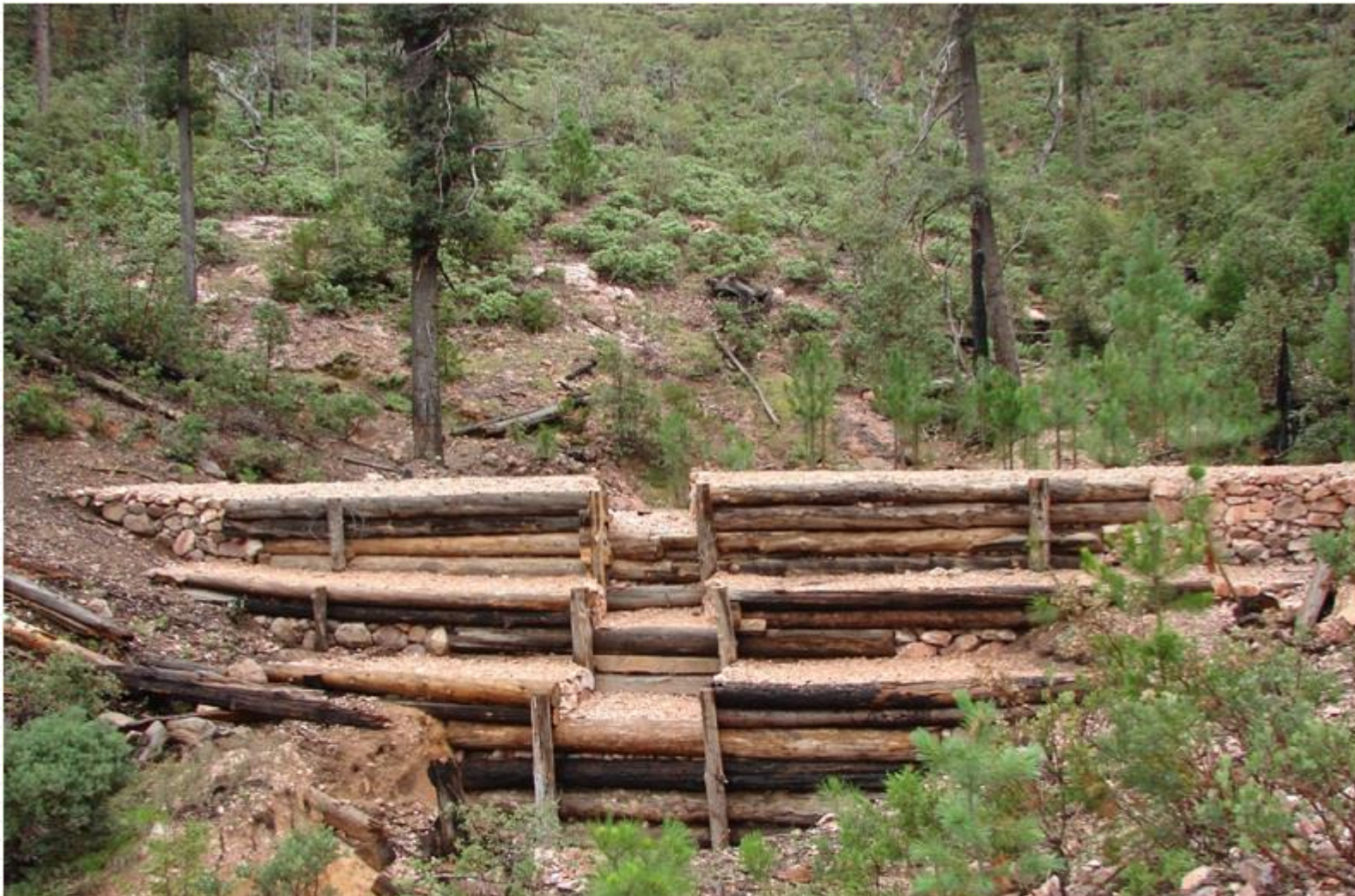
Presa de morillos y piedra acomodada para control de azolves. Ejido Catedral, Guadalupe y Calvo, Chih.
